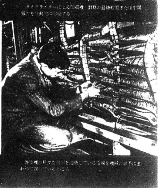
コンソールといわれる穿孔装置の制御と監視をするもの
